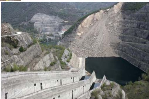
Κατολίσθηση Φράγματος Θησαυρού, 10 η Φεβρουαρίου 2008
