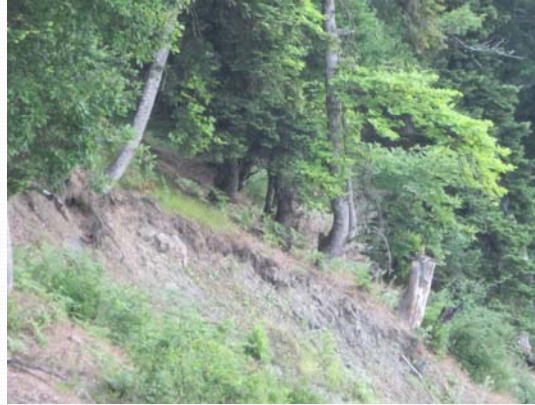
Κάμψη κορμών δέντρων εξαιτίας ερπυστικών μετακινήσεων σε πρανές στην περιοχή του Ροπωτού Τρικάλων.
